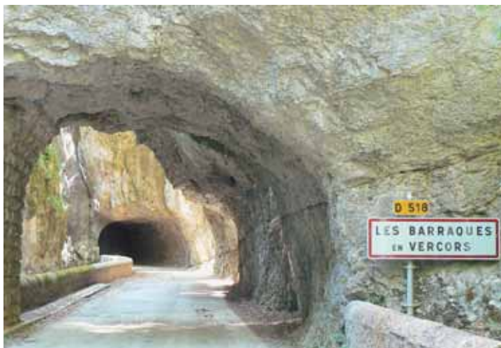
▲ Les Grands Goulets : route remise en état et définitivement fermée.
